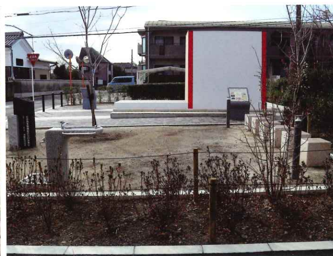
南内裏公園の外郭築地整備状況（北から）
